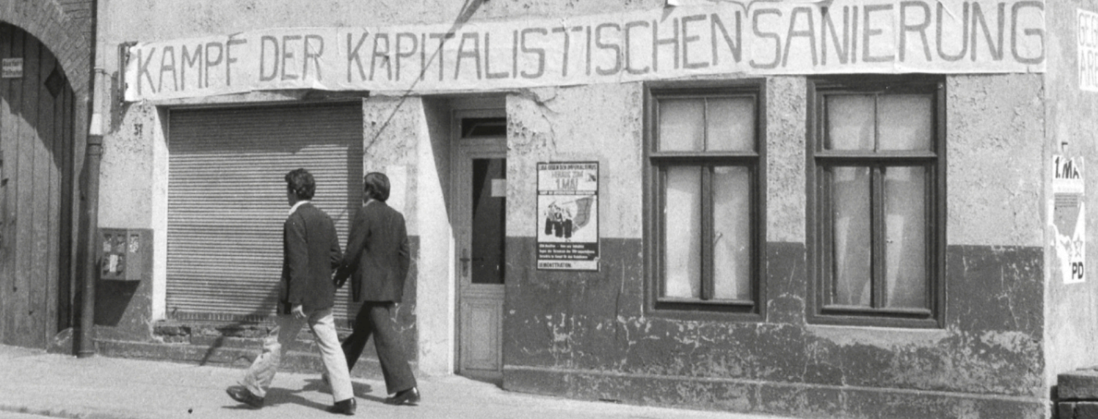
Wie in der Charlottenstraße und am Haus Ricklinger Straße 46 machten an vielen Stellen in Linden Süd Transparente den Widerstand und Protest gegen die Flächensanierung und totalen Abriss deutlich. Foto: Digitales Stadtarchiv Linden-Süd
